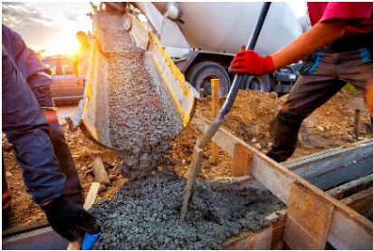
일반 콘크리트 공사
